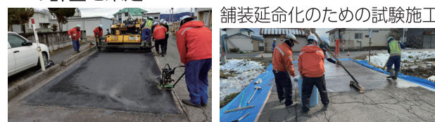
舗装延命化のための試験施工を実施
