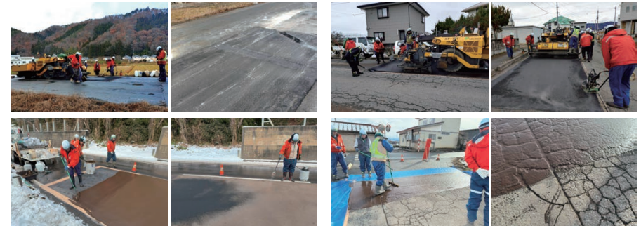
△上山市での施工の様子
