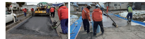
△ 舗装延命化のための試験施工を実施
