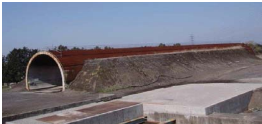
模擬トンネル全景
