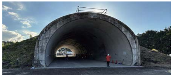
模擬トンネル全景(正面)
