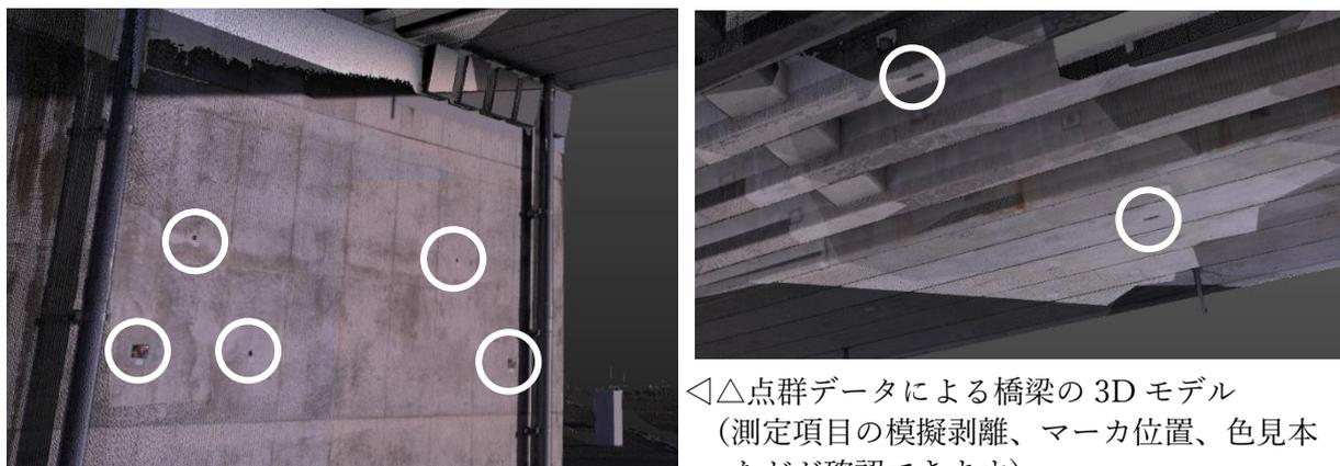
◁△点群データによる橋梁の 3D モデル (測定項目の模擬剥離、マーカ位置、色見本などが確認できます)
