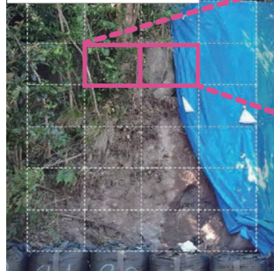
[対象のり面 (災害現場)]
