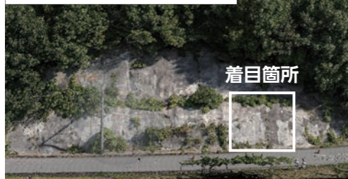
[対象のり面 (モルタル)]
