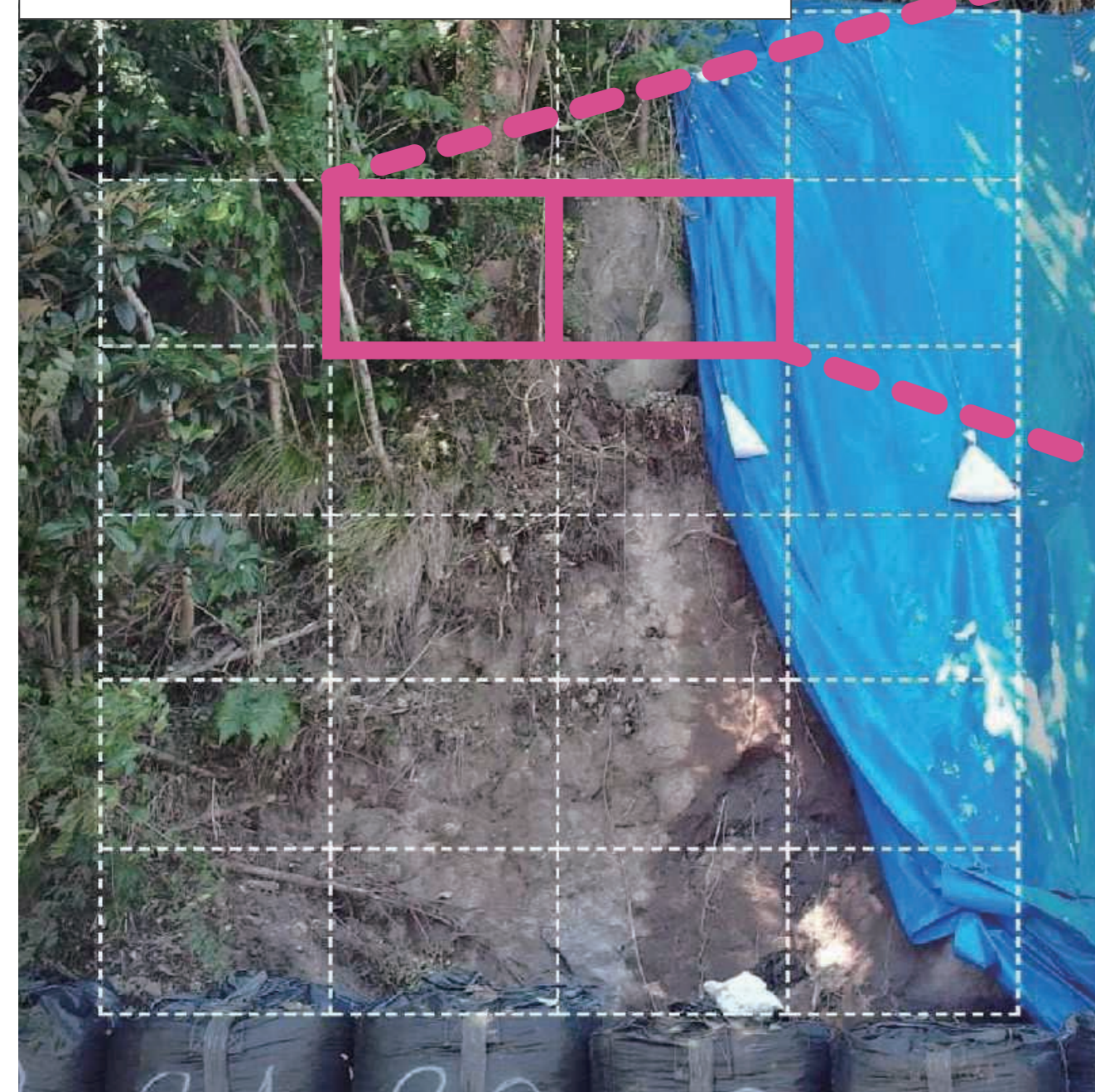
【対象のり面 (災害現場)】
