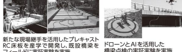
新たな現場継手を活用したプレキャストRC床版を産学で開発し、既設橋梁をフィールドで実証実験を実施
