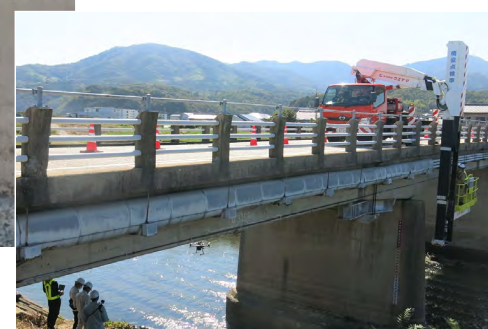
健全度Ⅲの橋梁で、補修対象が桁端部、桁下全体にあるため、ドローン点検と橋梁点検車を併用。
