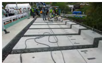
施工状況（2019年4月18日）
