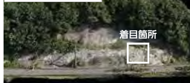
【対象のり面 (モルタル)】
