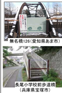
通行止め橋梁
