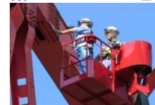
直轄診断(三島大橋)
